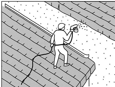
④壁面、その他モルタル塗り、リシン吹付けなどの吹付け作業に際しては、屋根面のシート養生を徹底するよう指示して下さい。
